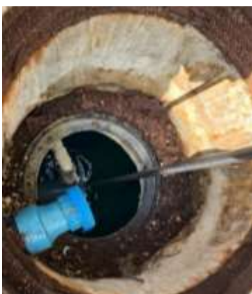
รูปที่ 3.2 จุติระบายน้ำออกจากระบบบำบัดน้ำเสีย บริเวณระบบบำบัดน้ำเสีย อาคาร C
